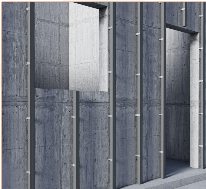
Устанавливаем лаги по ширине проемов с отступом 1 см
