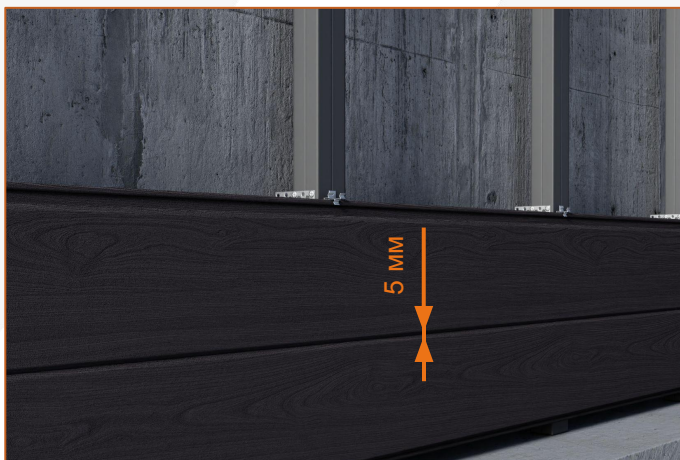
Монтаж второй и последующих фасадных панелей
