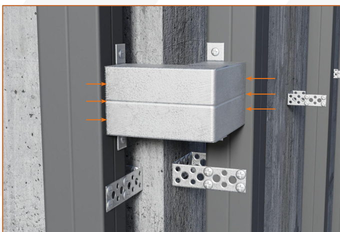
Устанавливаем оцинкованный угол с отступом внутрь подсистемы.
