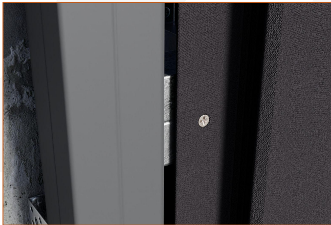
Установленный с зенкованием саморез
