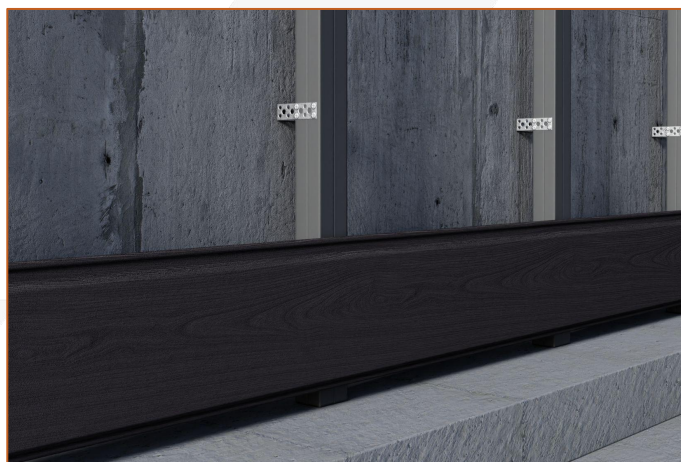
Монтаж первой фасадной панели
