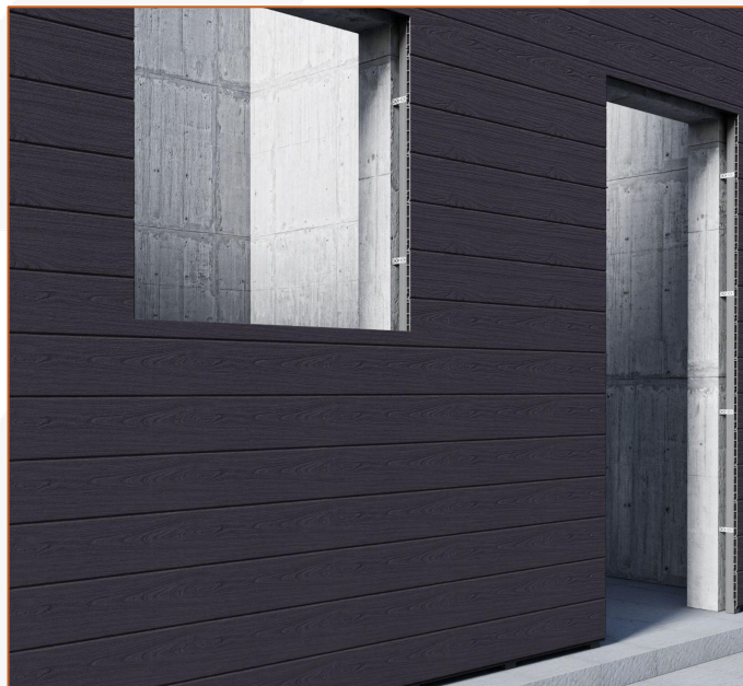
Финальный вид перед установкой откосов
